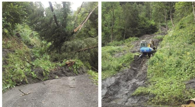
Bei der „Betfichte“ und im Bereich „Schönbichl“ waren durch die andauernden Regenfälle Hangrutschungen entstanden. Die Schadstellen konnten in kürzester Zeit durch die Firmen Laschalt und Erd Extrembau behoben werden.
